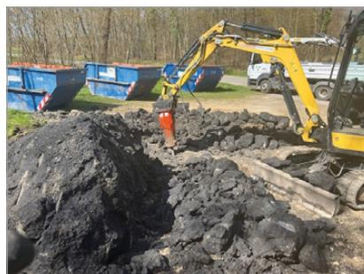
Mehrere Mitarbeiter des Service-Trupps und Fuhrparks arbeiteten einige Tage mit Hilfe eines 2,5-t-Baggers mit zusätzlichem Hydraulikhammer. Für die Entsorgung standen 3 große Absetzcontainer bereit, die aber nicht ausreichten. Eine weitere Fuhre wurde mit dem LKW direkt auf die Deponie gebracht. Leider konnte der Verursacher nicht ermittelt werden.
