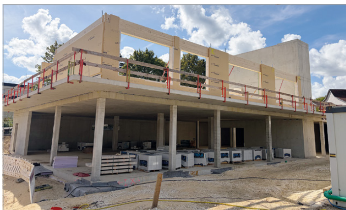
Das Bild zeigt das Untergeschoss, in dem die Mensa untergebracht wird und darüber die ersten montierten Holzbauteile. Foto: Stadt Aalen
